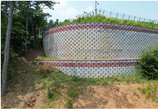
손상내용 옹벽 시점부 상태양호
