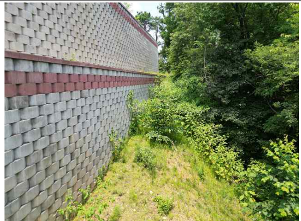
옹벽 하부 전경
