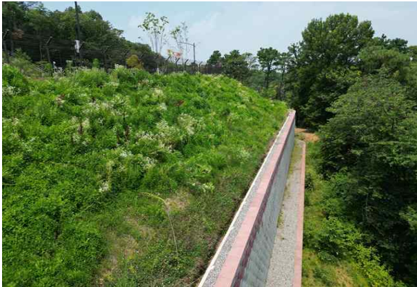
손상내용 옹벽 상부 상태양호
