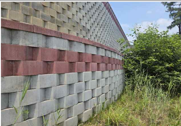
손상내용 옹벽 하부 상태양호
